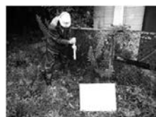
ボーリングバー 削孔状況
