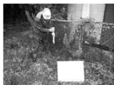
ボーリングバー 削孔状況
