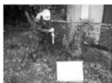
ボーリングバー 削孔状況
