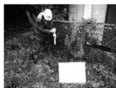
ボーリングバー 削孔状況
