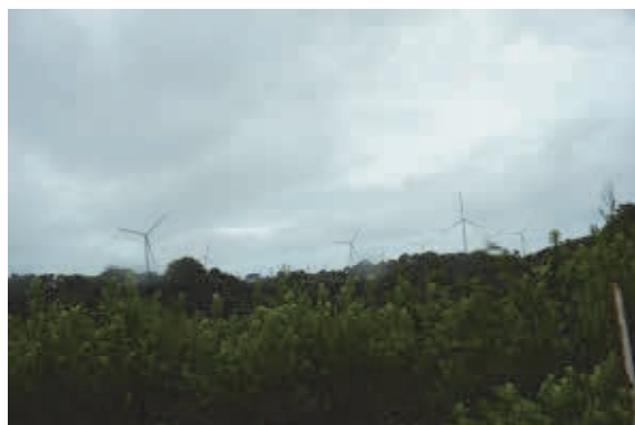
バスの車窓からの陸上風力発電施設
